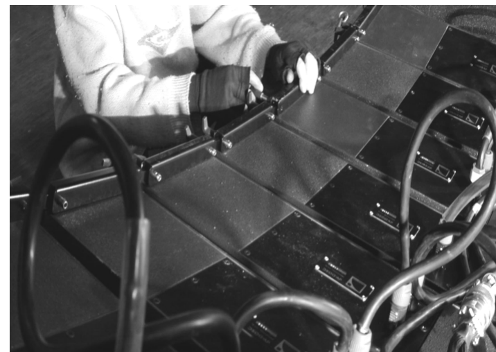
(x) ... Attacher les dV-ANGLE à l'aide des dV-PIN.
